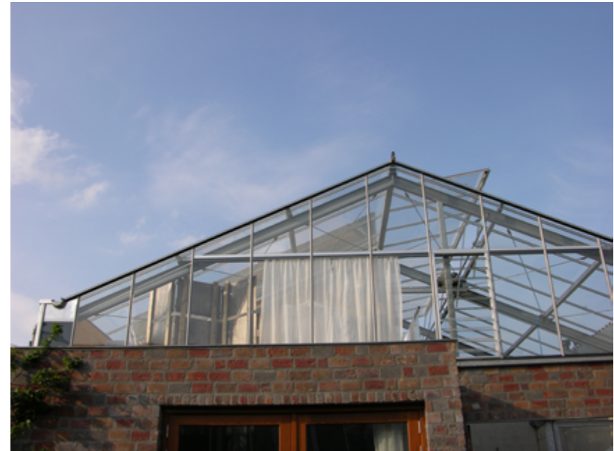
Bij deze kaswoning gaat het kasdek in de zomer automatisch open om oververhitting te voorkomen.
