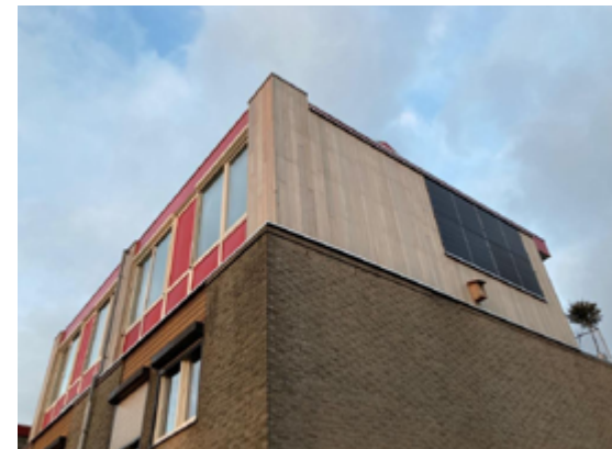
Zonnecellen op de zuidgevel zullen ook in de winter, wanneer de zon laag staat, stroom produceren. Per m 2 is er gemiddeld 25kWh energie-instraling in de maand december.
