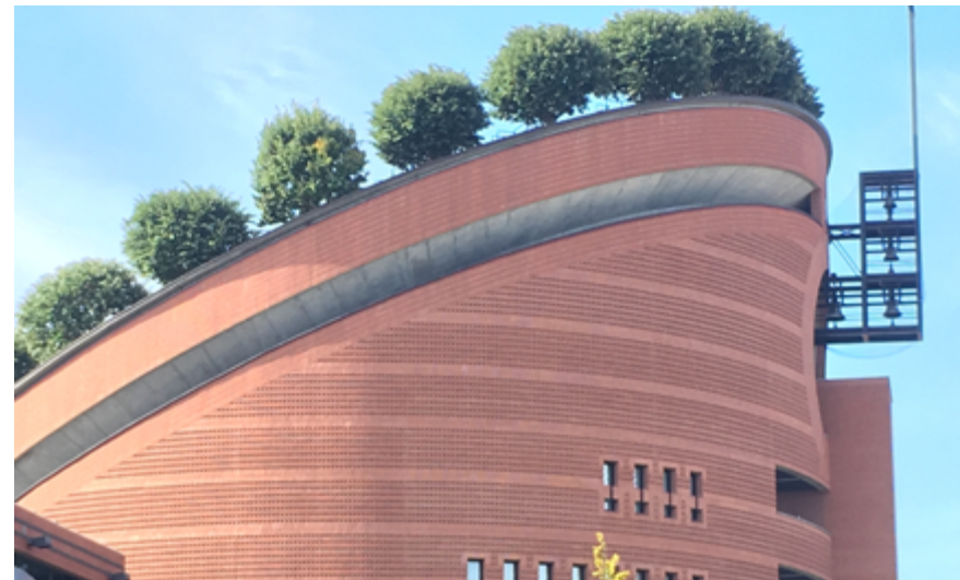
Bomen op hogere gebouwen hebben grote visuele impact; de architect en constructeur dienen daarbij vanaf het begin rekening te houden met de dakbelasting en de invloed van wind. Ontwerp: Mario Botta, kathedraal Evry.
